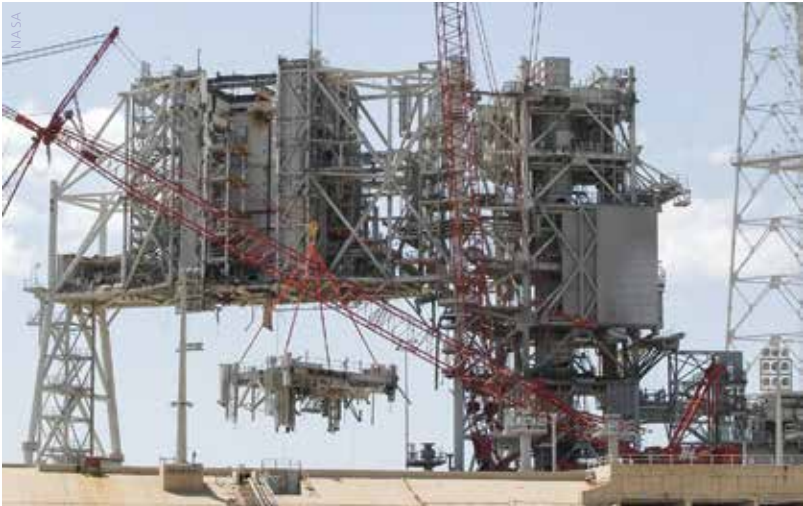
Dann begann die Demontage.
